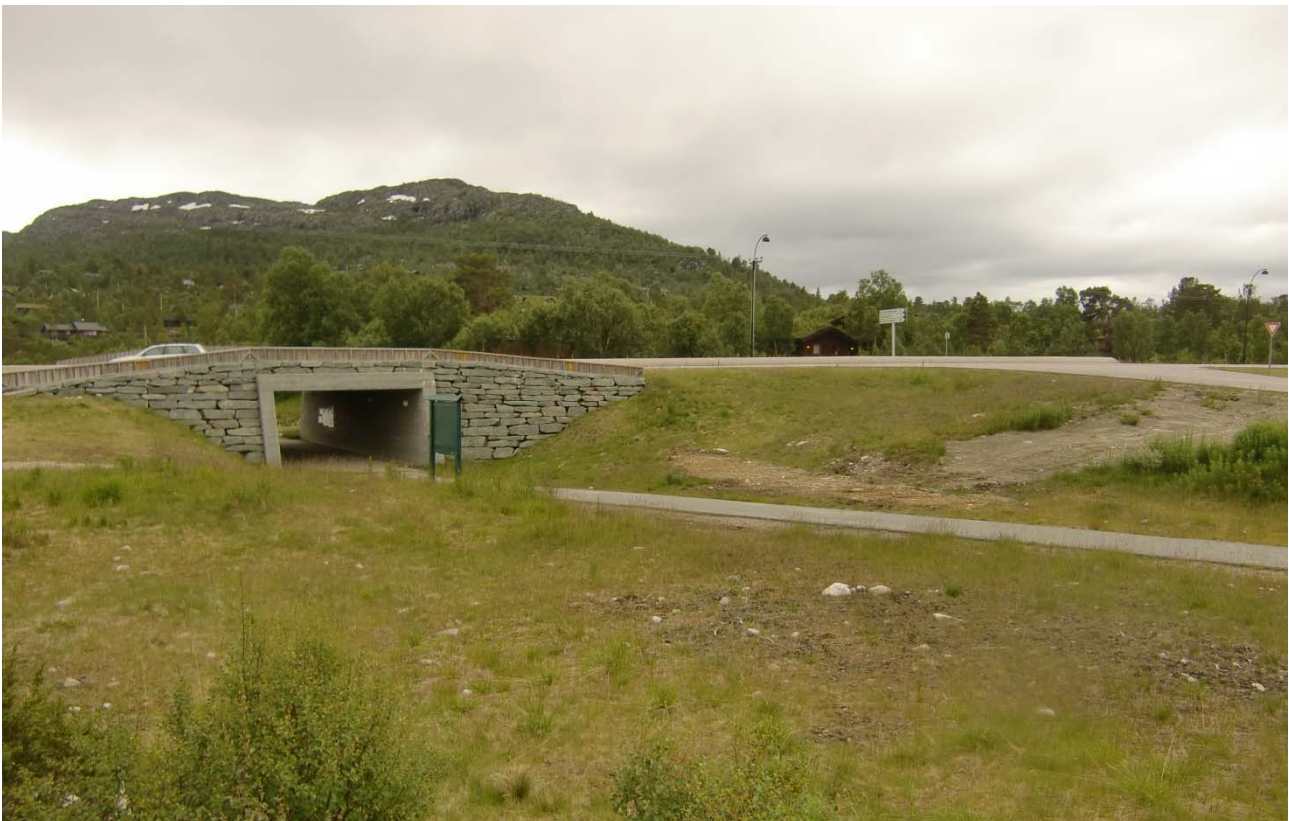
Figur 12: Kulvert for skiløype (Kilde: egne foto)
