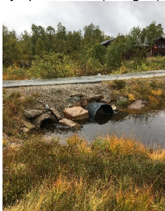
Fig. 3 Stikkrenner gjennom Fjellparkveien
